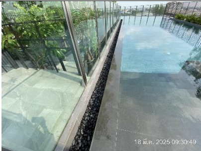
รูปที่ ผ7.59 ท่อระบายน้ำล้นมีฝาปิดรอบสระน้ำ
