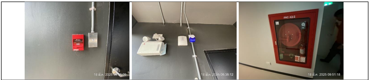
รูปที่ ผ7.56 ระบบแจ้งเตือนอุปกรณ์ส่งสัญญาณเตือนเพลิงไหม้ และอุปกรณ์ช่วยดับเพลิง
