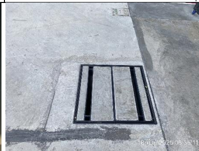
รูปที่ ๗.52 ตะแกรงครอบตามรูปท่อ และท่อระบายน้ำทั้งภายในและภายนอกอาคาร
